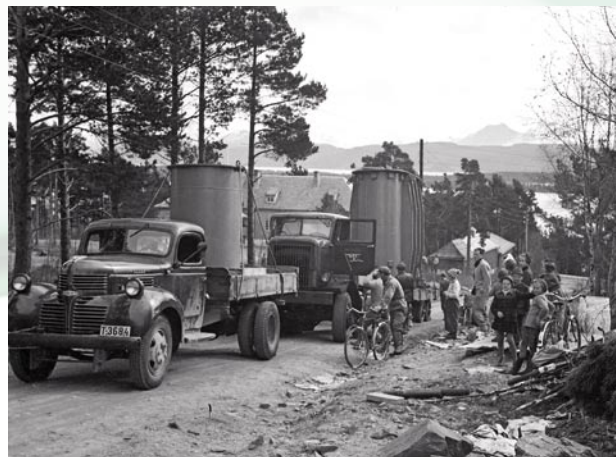
Den første trafoen til Moldeli trafostasjon ble transportert fra havna på lastebil. Her er transporten på veg opp Bolsøyvegen mot Langmyra. Over taket på den bakerste bilen skimtes gamle Fuglset skole.
