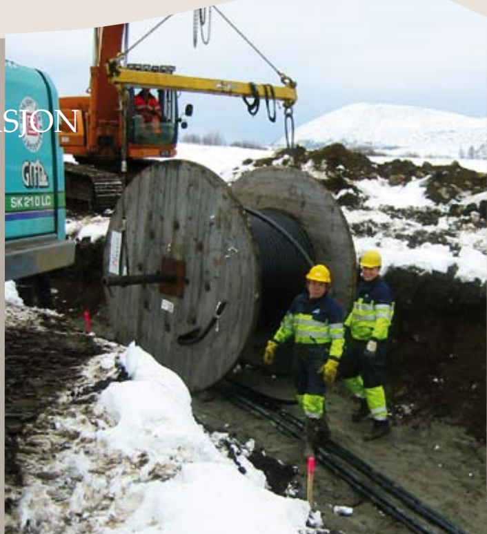
Legging av 132 kV kabel mellom Fræna transformatorstasjon og Hustadmarmor.
