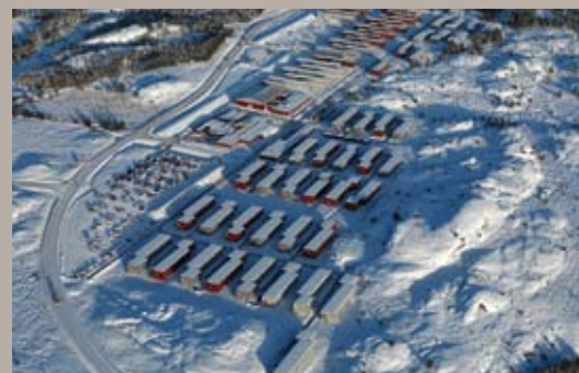
Overnattingsriggene på Nyhamna ga sengeplasser til 3.000 arbeidere.
