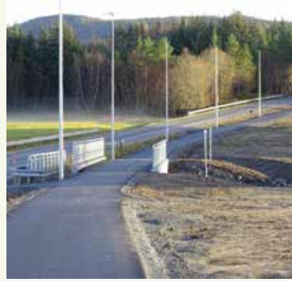
Ny gang-og sykkelvei med belysning, med kabel i OPI kanal
