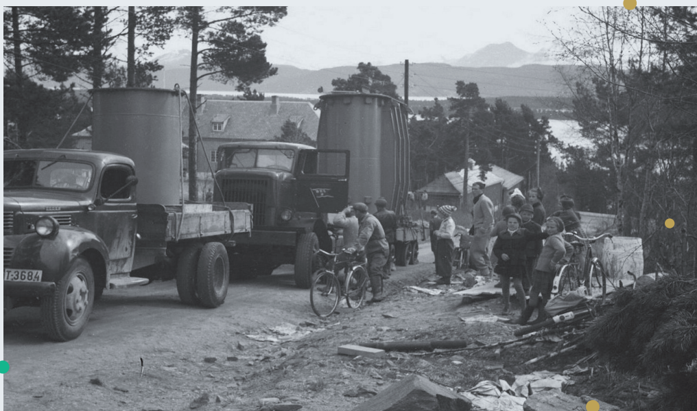
Trafoer ved Langmyra ca. 1950
